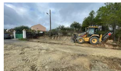
Ampliação da rede de abastecimento em Escalos de Cima
